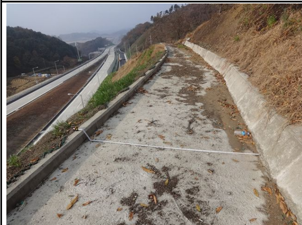
소단배수로 제원 측정
