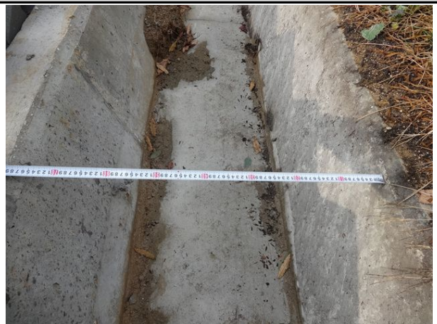
산마루측구 제원 측정
